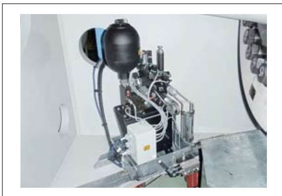
図 54 油圧ユニット
